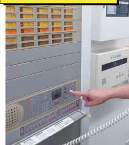
自動火災報知設備点検
