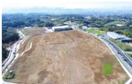
造成工事が進む分譲地
