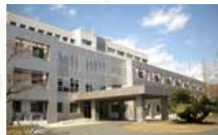
国立遺伝学研究所研究本館耐震改修
