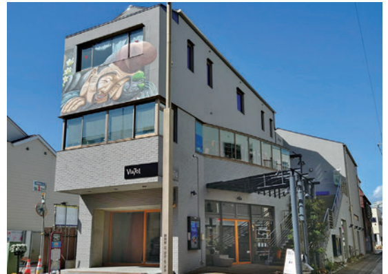
リニューアルした Via701 の外観
