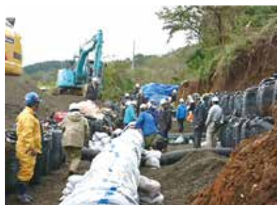
災害復旧工事
