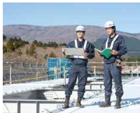
国道 138 号バイパス床板工事 御殿場市
