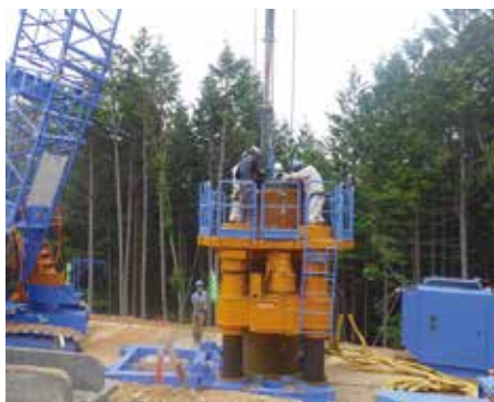
飛騨信濃直流幹線鉄塔基礎工事 岐阜高山市
