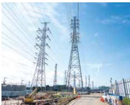
リニア中央新幹線 鉄塔建設工事 相模原市
