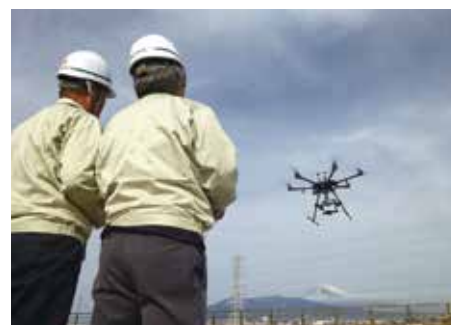
ドローンによる測量
