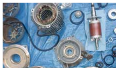
給水ポンプオーバーホール状況
