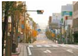
電線類地中化完成
